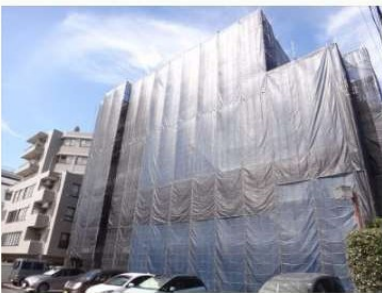
ビル改修工事（足場組立工事）の実施
