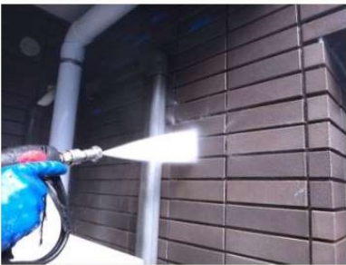
ビル改修工事（高圧水洗・クリーニング工事）の実施
