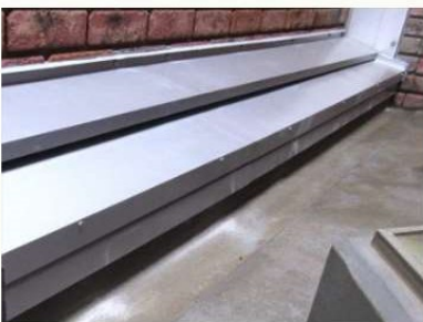
ビル改修工事（金物工事）の実施
