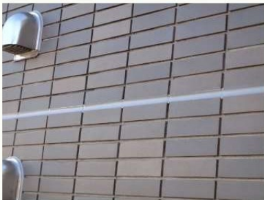
ビル改修工事（シーリング工事）の実施
