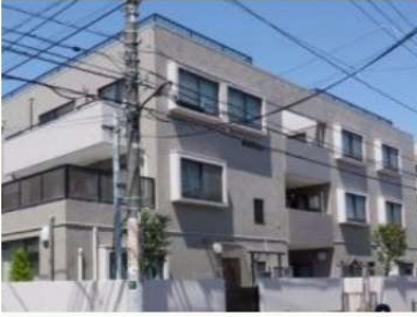
集合住宅の外壁改修工事の実施
