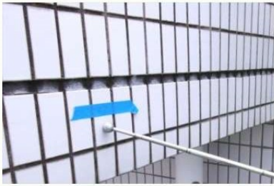
ビル改修工事（外壁調査・下地補修工事）の実施
