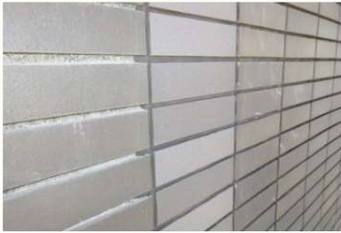
ビル改修工事（タイル補修工事）の実施
