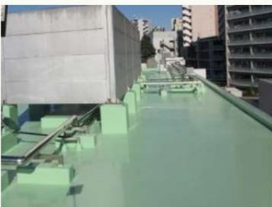
公共施設にて屋上の防水・鉄部塗装工事の実施
