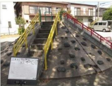
公園遊具の塗替え工事の実施
