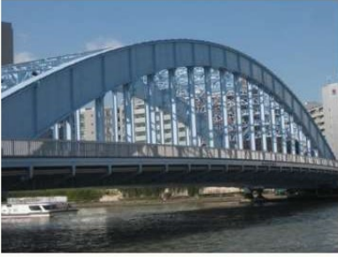
橋梁の塗替え工事の実施
