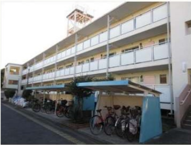
公共アパートの共用部鉄部塗装工事の実施
