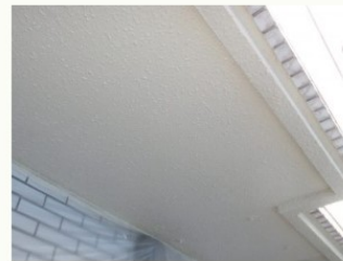
マンション改修工事（塗装工事）の実施
