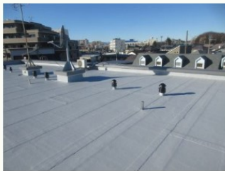
マンションの大規模修繕工事（アスファルト防水工事）の実施
