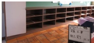
中学校の教室の塗替工事の実施
