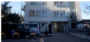
児童館の外壁の塗替え工事の実施
